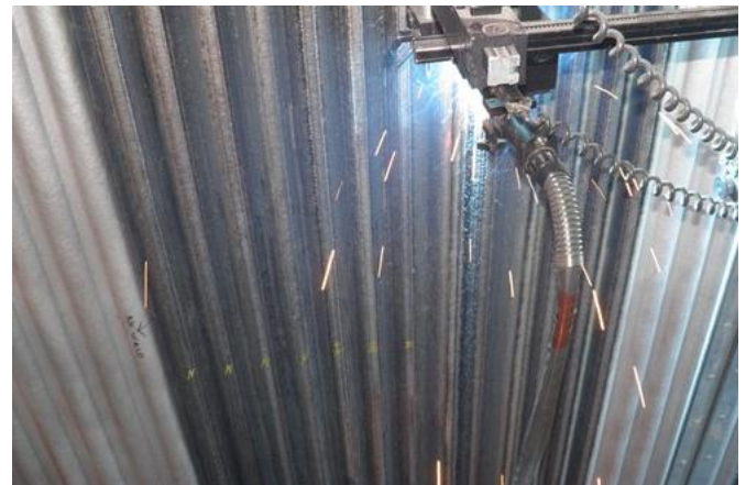
Рис 2: Процесс автоматической наплавки на мембранный экран
