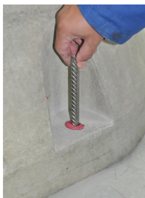
Рис 6б. Установка арматуры
