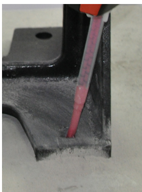
Рис 9а. Заполнение композитным раствором
