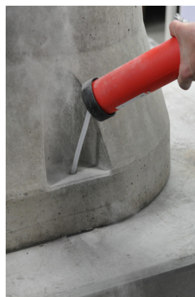
Рис 5с. Продувка просверленных отверстий
