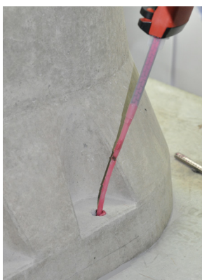
Рис 6а. Заполнение раствором
