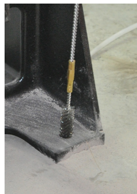
Рис 8д. Очистка просверленных отверстий
