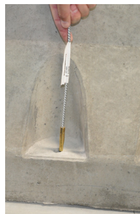
Рис 5д. Очистка просверленных отверстий
