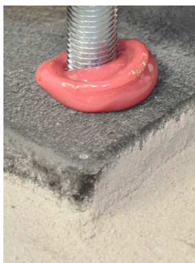
Рис 9б. Установка шпильки
