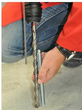
图 8b 调整钻孔深度
