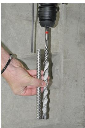
图 5a 调整钻孔深度
