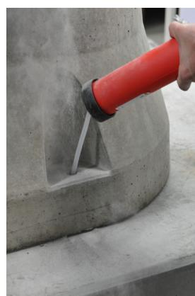
图 5c 将钻孔吹干净
