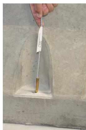
图 5d 将钻孔刷干净
