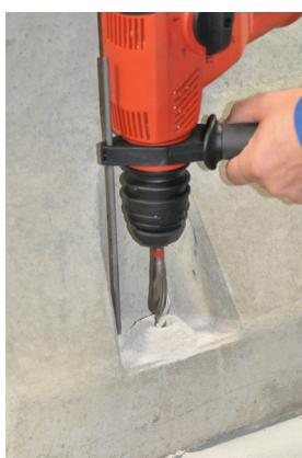
图 5b 钻固定孔
