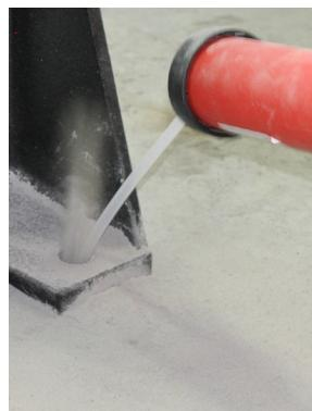
图 8c 吹扫钻孔
