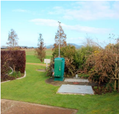
Bonita vista desde el exterior de la estación
