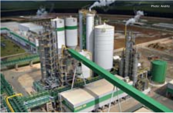
3 Das Veracel-Zellstoffwerk in Eunapolis, Bundesstaat Bahia (BR), gehört Stora Enso und Aracruz Celulose. Seit 2005 produziert das Werk jährlich 900 000 t Zellstoff aus Eukalyptusholz. Pumpen und Mischer von Sulzer sind hier im Einsatz.
