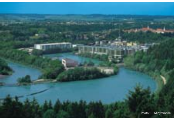
4 Das Werk Schongau von UPM-Kymmene am Lech in Schongau (DE). Es produziert Zeitungspapier und andere Spezialqualitäten mit einer Jahreskapazität von 730 000 t. Bereits 1991 stellte das Werk Zeitungspapier aus 100% Altpapier her.
