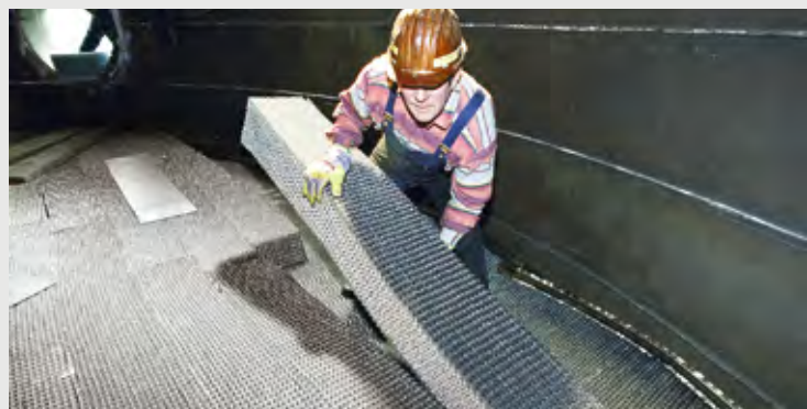
Abb. 3 Segmentweiser Einbau von strukturierten Packungen in eine Kolonne.
