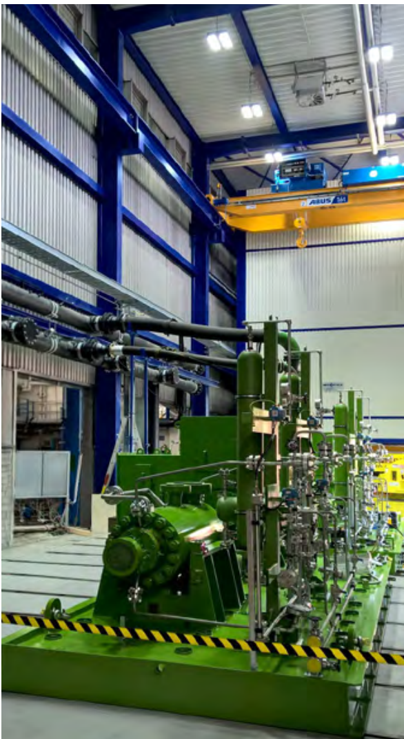
1 Die neue Prüfstandserweiterung mit Laufkranen.
