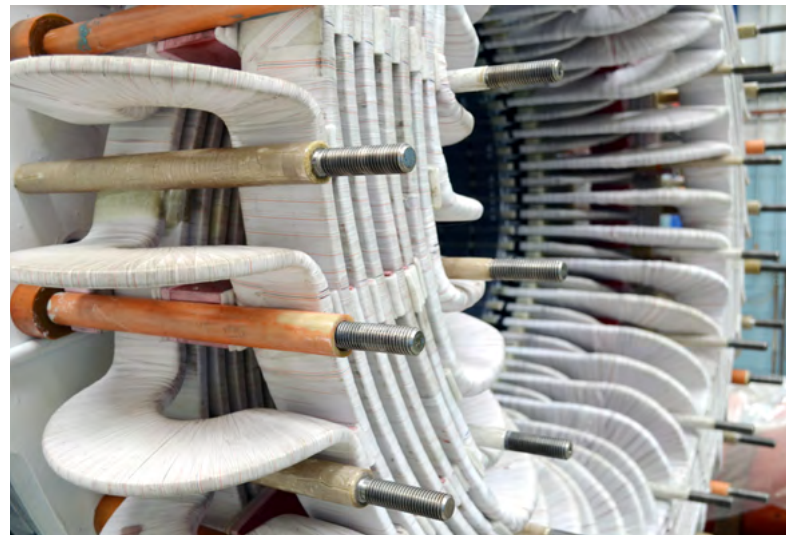
3 Präzise Montage von 72 Hairpin-Coils im Generator.
