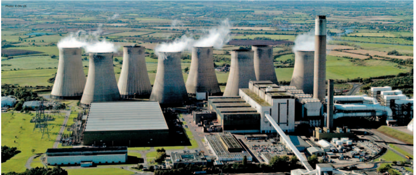
Das 1968 in Betrieb genommene Kraftwerk Radcliffe-on-Soar hat eine markante Lage im Tal des River Trent in Nottinghamshire, England. Das Kraftwerk umfasst vier kohlebefeuerte Kessel und hat eine Gesamtleistung von über 2000 MW.
