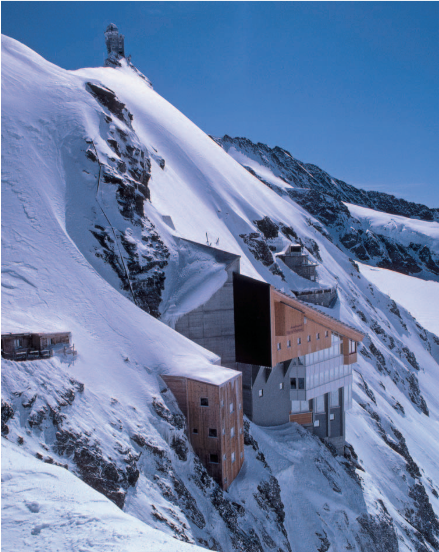
Gute Wärmedämmsysteme reduzieren den Energieverbrauch enorm. Dies auch auf dem 3454 Meter hohen Jungfrauoch mit Jahresdurchschnittstemperaturen von -10^{\circ}\text{C} .
