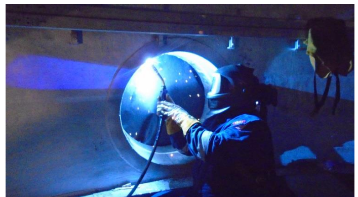
Figura 3: Reparação do bocal
