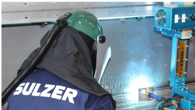
Figura 1: Soldagem de revestimento automatizada
