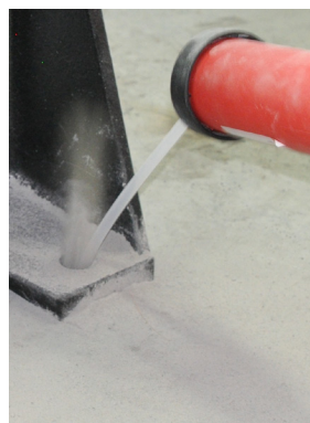
Εικόνα 8c: Καθαρισμός των οπών με πεπιεσμένο αέρα
