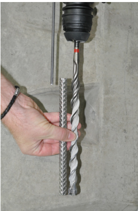
Εικόνα 5a: Ρύθμιση του βάθους διάτρησης
