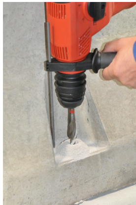
Εικόνα 5b: Διάνοξη των οπών στερέωσης
