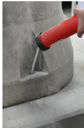
Εικόνα 5c: Καθαρισμός των οπών με πεπιεσμένο αέρα
