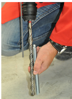
Εικόνα 8b: Ρύθμιση του βάθους διάτρησης
