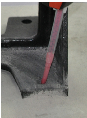
Εικόνα 9a: Πλήρωση με κονίαμα ένωσης
