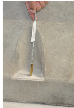
Εικόνα 5d: Βούρτσισμα της οπής
