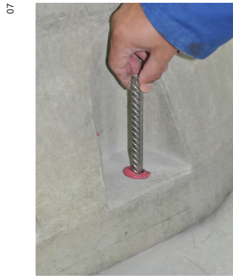
Εικόνα 6b: Τοποθέτηση του οπλισμού
