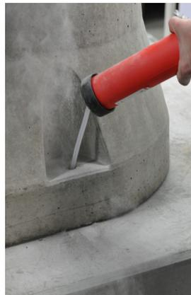
*Bild 5c Bohrung ausblasen*
