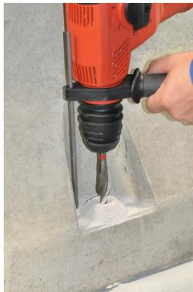
*Bild 5b Befestigungslöcher bohren*
