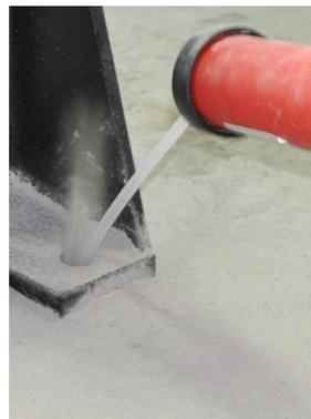
Bild 8c Bohrloch ausblasen
