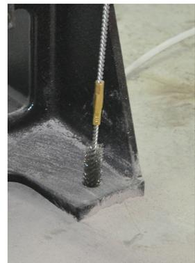
Bild 8d Bohrloch säubern
