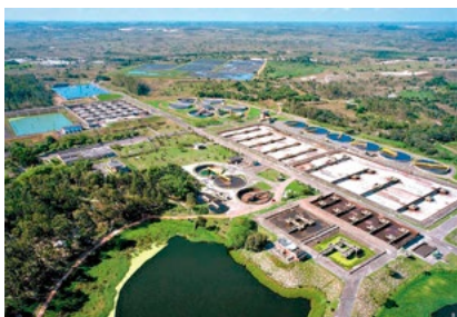
Cetrel - Planta de tratamento de efluentes industriais em Camaçari/Bahia-Brasil
