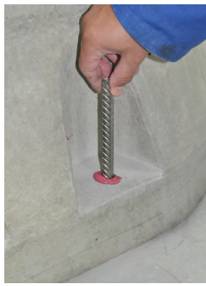
6b. ábra Vasalás behelyezése
