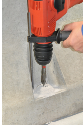
5b. ábra A rögzítőlyukak kifúrása
