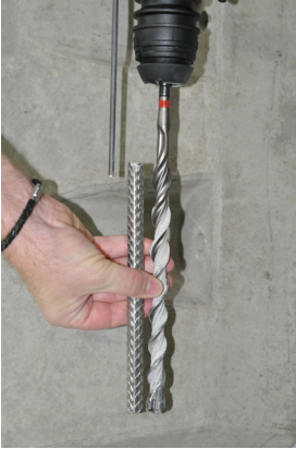
5a. ábra Fúrési mélység beállítása
