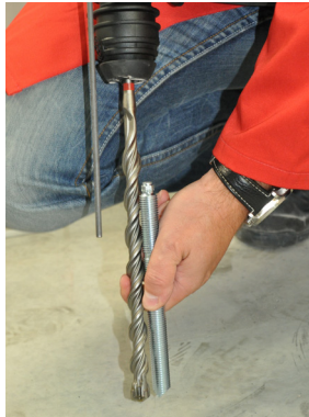
8b. ábra Fúrás mélység beállítása
