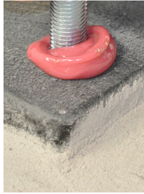
9b. ábra Stift bevezetése
