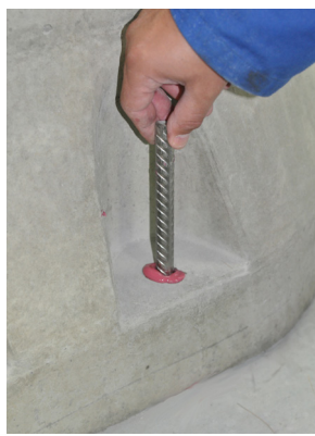
Rys. 6b Zakładanie zbrojenia
