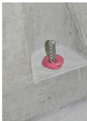
Rys. 6b Zakładanie zbrojenia
