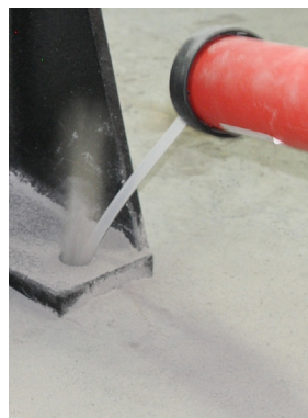
Rys. 8c Wydmuchać otwór
