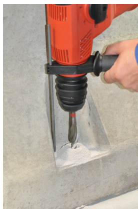
Rys. 5b Wykonać otwory mocujące
