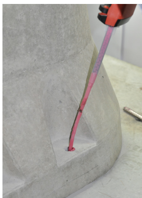
Rys. 6a Wypełnianie zaprawą
