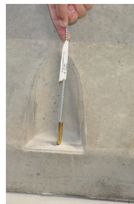
Rys. 5d Udroźnić otwory
