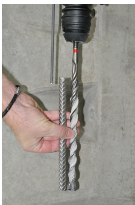
Rys. 5a Ustawić głębokość wiercenia
