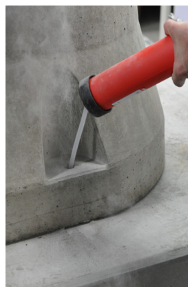
Rys. 5c Wydmuchać otwory
